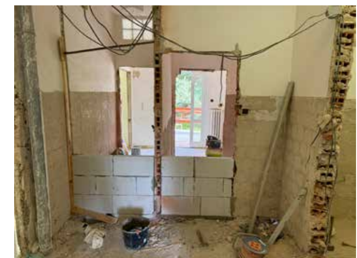
Rekonstrukce sociálního zázemí a čekárny.
