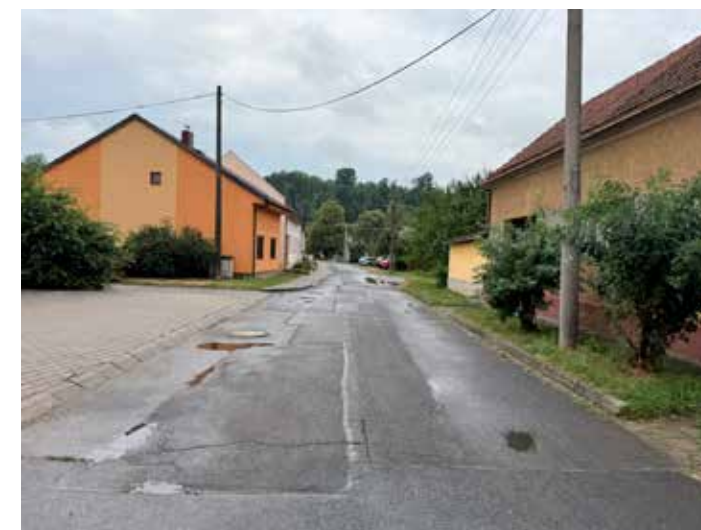
Hájek před rekonstrukcí místní komunikace. Foto: 45x archiv OU.
