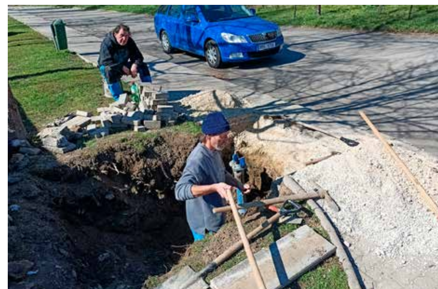
Práce na novém nadzemním hydrantu.
