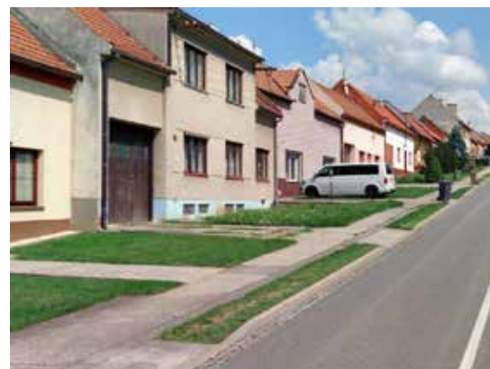
Stávající chodník k rekonstrukci ul. Dědina
