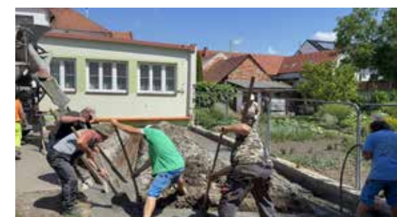
Betonáž základů přístavby OÚ - zaměstnanci obce
