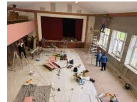
Kulturní sál při modernizaci
