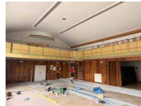
Kulturní sál při modernizaci
