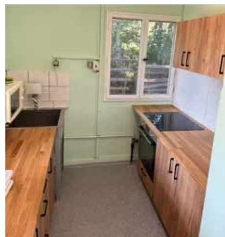
Myslivecká chata po opravě
