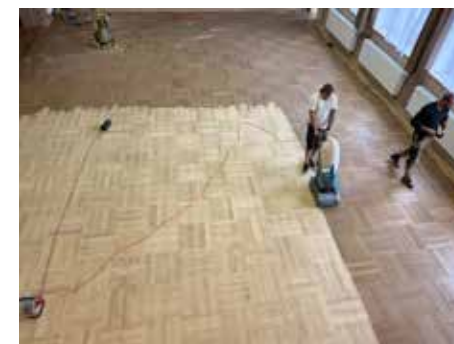
Kulturní sál při modernizaci
