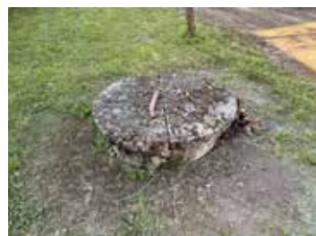
Původní stav studny u sportovní haly
