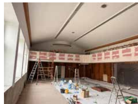
Kulturní sál při modernizaci.
