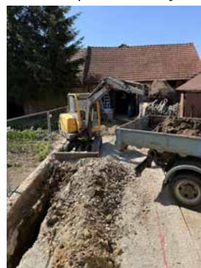
Výkop rýhy pro základy - přístavby OÚ
