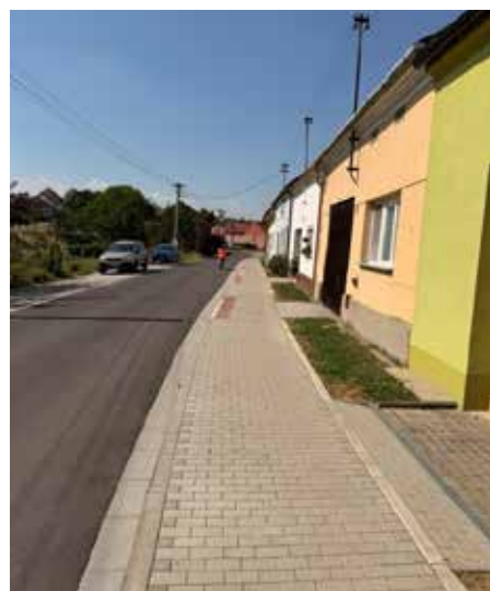
Rekonstruovaný chodník ul. Hájek
