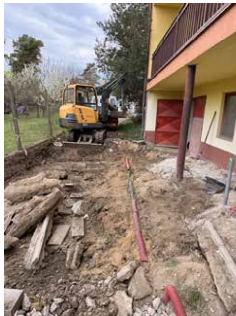
Probíhající práce za MŠ
