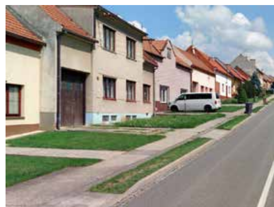
Stávající chodník k rekonstrukci ul. Dědina
