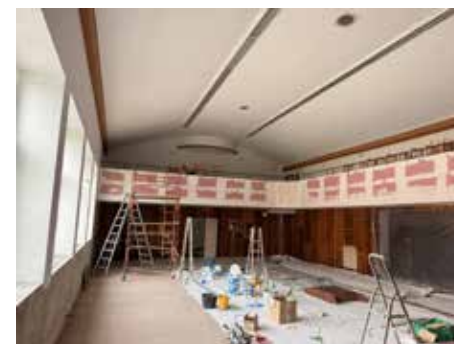
Kulturní sál při modernizaci.
