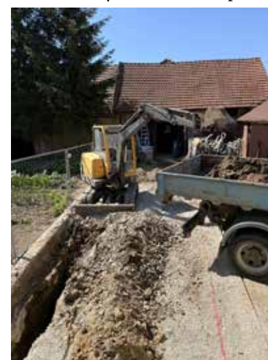
Výkop rýhy pro základy - přístavby OÚ
