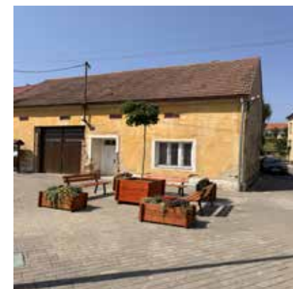
Úprava veřejného prostoru po autobusové zastávce u OÚ
