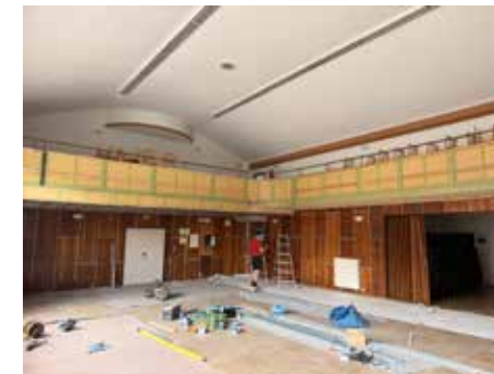
Kulturní sál při modernizaci
