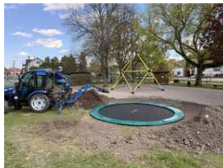
Montáž trampolíny - terenní úpravy - VI. Maluš.
