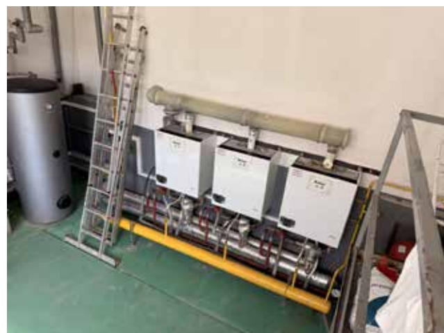
Stávající kotelna ZŠ
