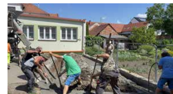
Betonáž základů přístavby OÚ - zaměstnanci obce
