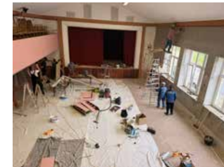
Kulturní sál při modernizaci
