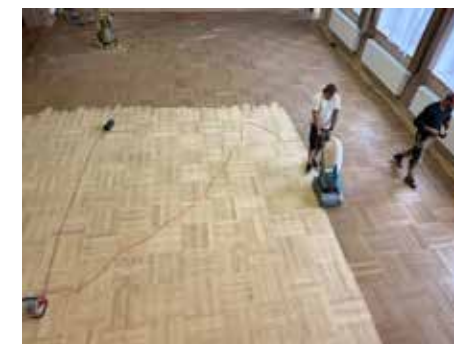
Kulturní sál při modernizaci
