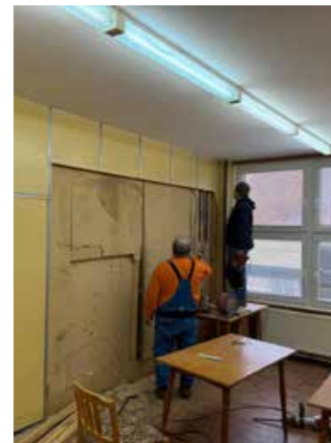
Prostory společenské místnosti v hale při rekonstrukci - prostor nové kuchyňky
