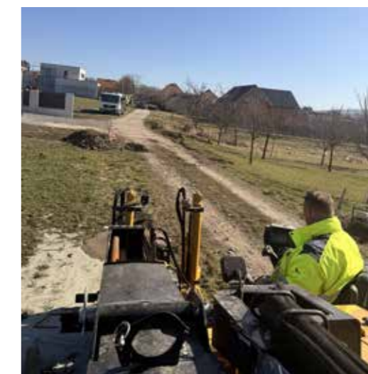
Realizace rozvodů VO a HDPE v lokalitě Zahumny - bezvýkopová metoda
