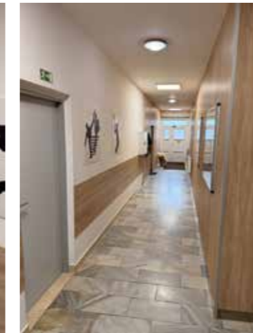
Chodba ve sportovní hale po rekonstrukci
