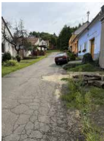
Ulice Hájek před rekonstrukcí.
