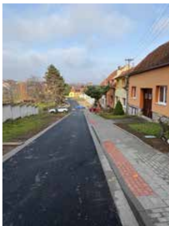
Ulice Hájek po rekonstrukci.
