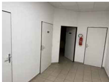
Původní stav na OÚ.
