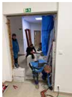
Modernizace na OÚ.
