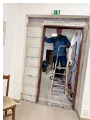
Modernizace na OÚ.
