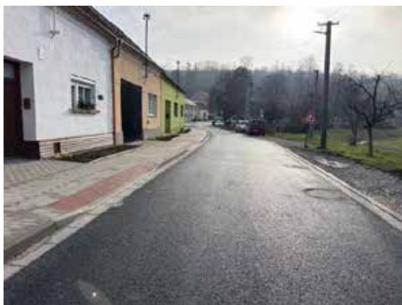
Ulice Hájek po rekonstrukci.
