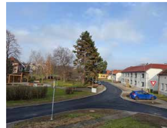
Ulice Hájek po rekonstrukci.
