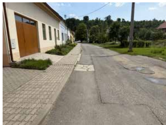
Ulice Hájek před rekonstrukcí.
