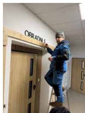
Modernizace na OÚ.
