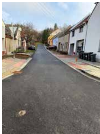
Ulice Hájek po rekonstrukci.
