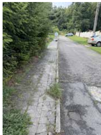
Ulice Hájek před rekonstrukcí.
