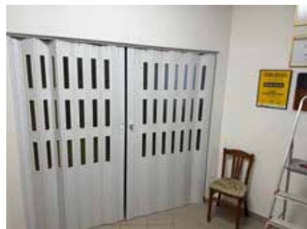
Původní stav na OÚ.
