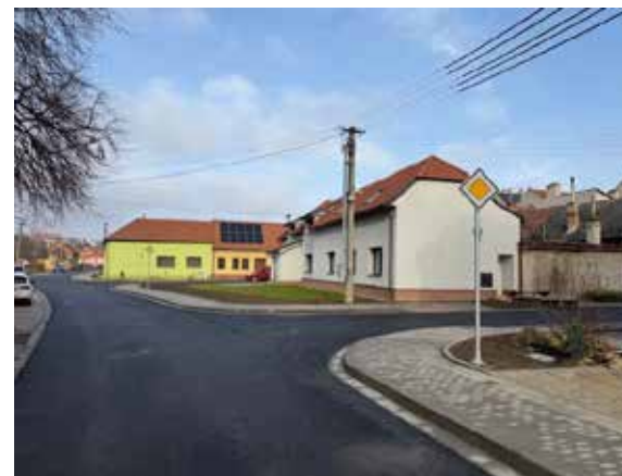
Ulice Hájek po rekonstrukci.
