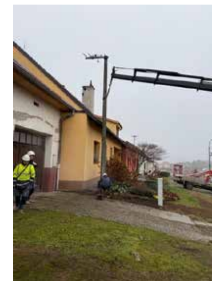
Odstranění sloupů pro rozvod NN v ul. Dědina.
