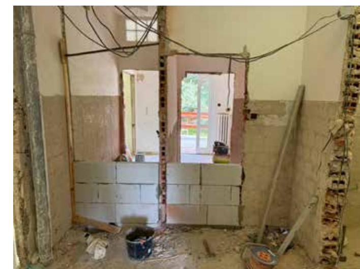
Rekonstrukce sociálního zázemí a čekárny.
