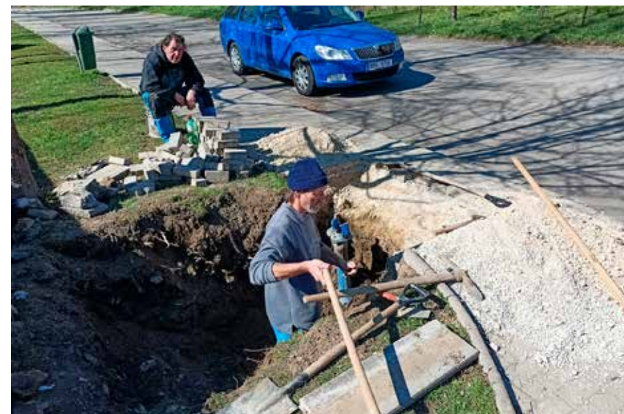
Práce na novém nadzemním hydrantu.
