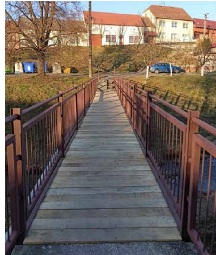
Výměna podlahy na lávce u Placu
