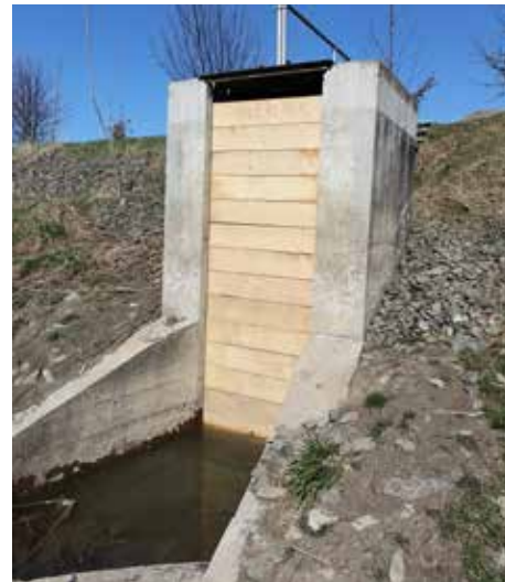
Nová výdřeva na stavidle Víceúčelové nádrže Veselská Padělky
