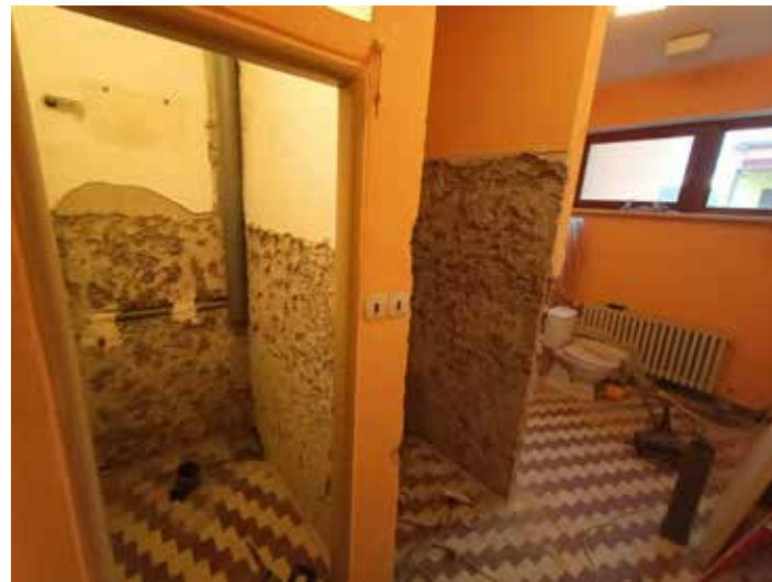
Šatna, WC, sprcha při rekonstrukci
