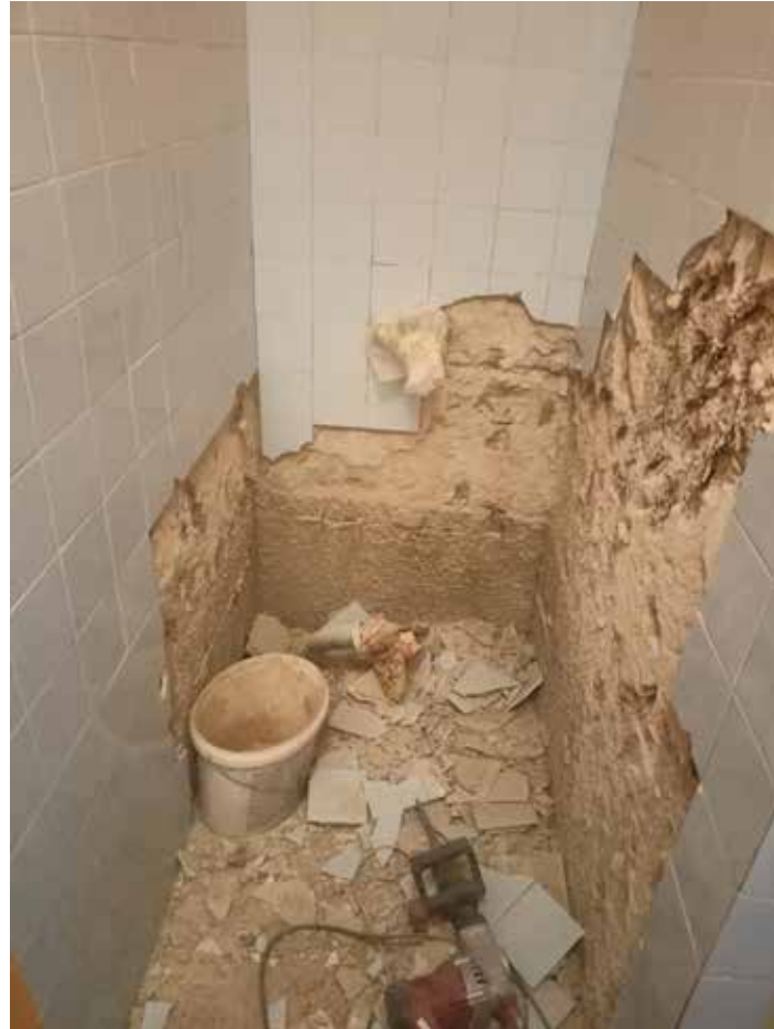
WC, při rekonstrukci
