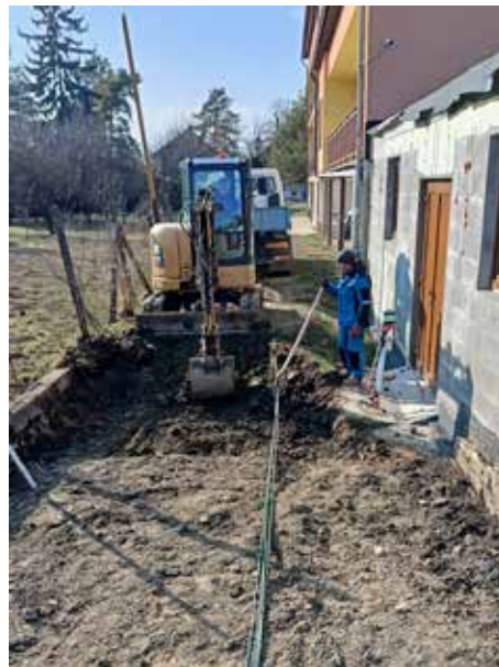
Rekonstrukce kanalizace za MŠ – zemní práce
