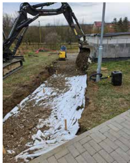
Práce na chodníku za MŠ
