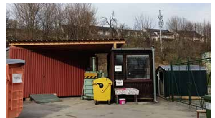
Nové zastřešení pro lis nový sklad nářadí na SD – provedeno svépomocí
