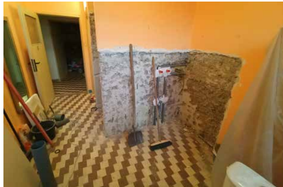
Šatna při rekonstrukci
