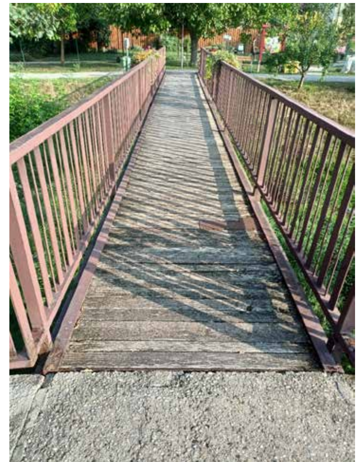
Lávka u Placu před výměnou podlahy
