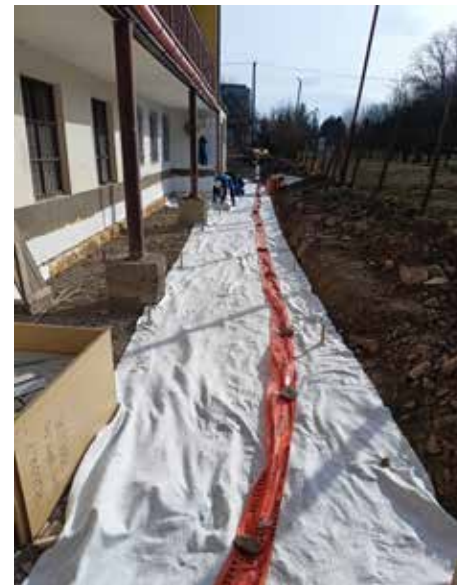
Práce na chodníku (zpevněné ploše) za MŠ
