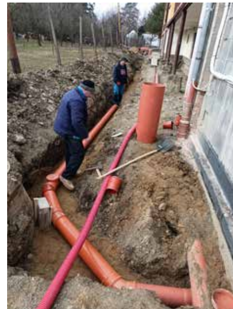
Rekonstrukce kanalizace za MŠ vč. napojení nové posilovny
