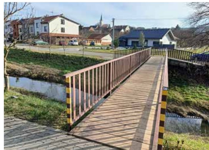
Nová podlaha na lávce u Placu
