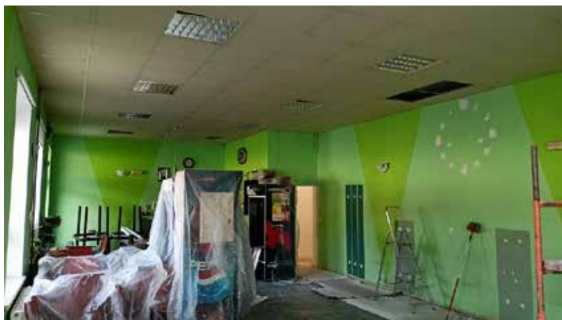
Obr. 2 oprava prostor pohostinství Na obecním; Obr. 3 prostory pohostinství po opravě ; Obr. 3a prostory pohostinství po opravě, foto RT
