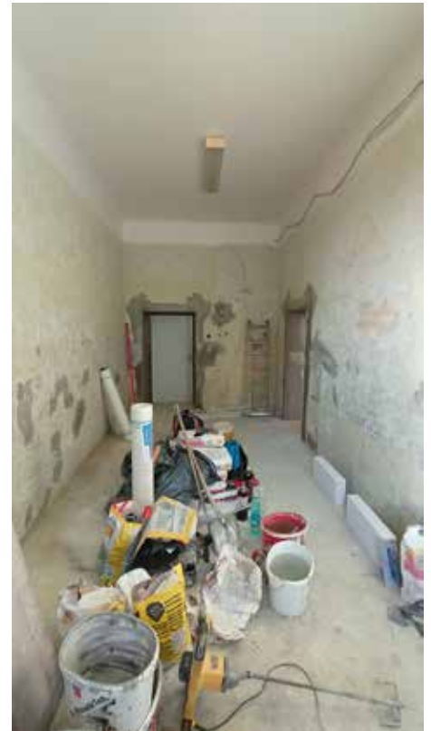
Obr. 5 práce při rekonstrukci šaten
