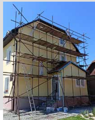
Oprava fasády na budově pošty
