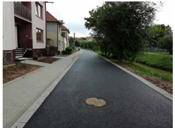
Ul. Řádek po rekonstrukci (chodník)
