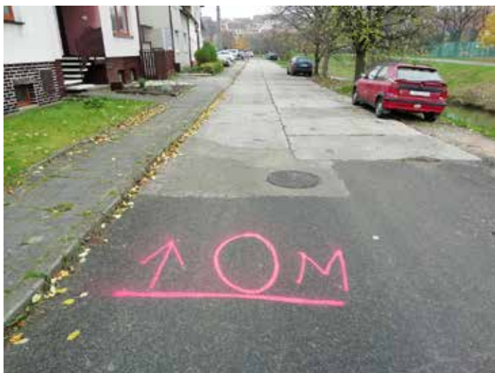
Ul. Řádek před rekonstrukcí (chodník a cesta)
