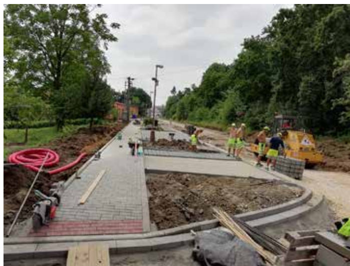
Stavební práce před MŠ
