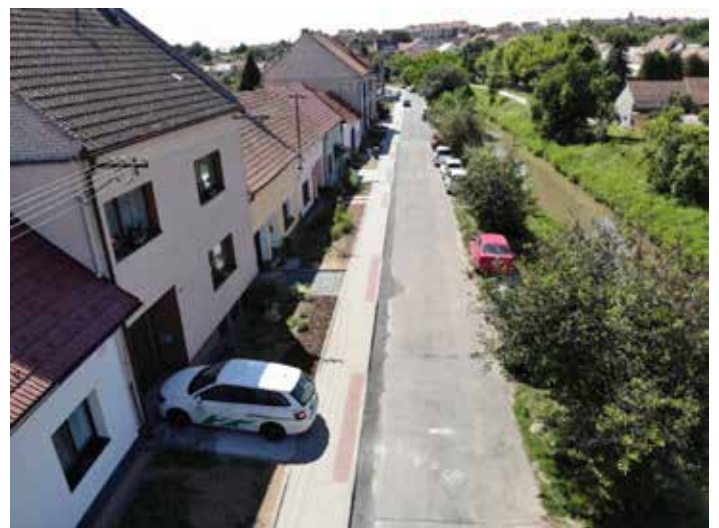
Ul. Řádek po rekonstrukci (chodník)
