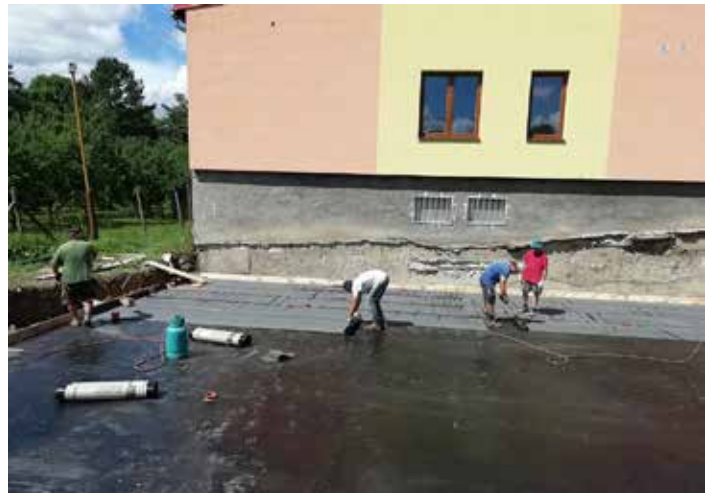
Montáž hydroizolace
