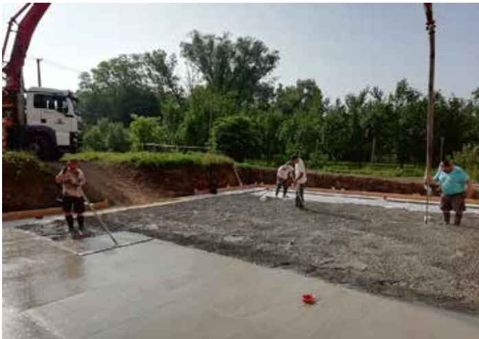
Betonáž podkladního betonu
