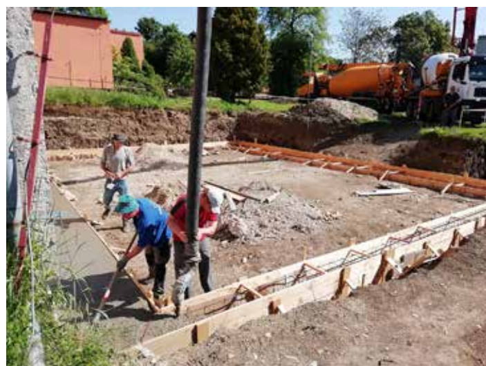
Členové kulturistiky vážou armokoše a začíšťují základovou spáru.
