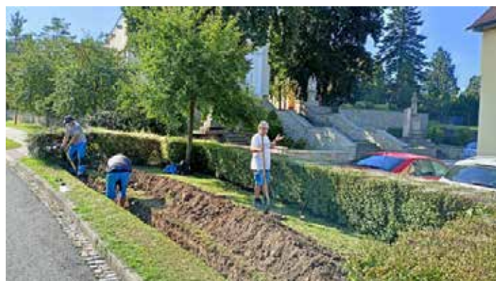
Úprava prostor před poštou
