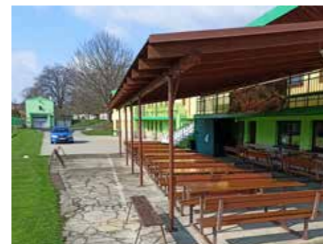
Podlaha před rekonstrukcí
