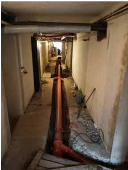
Rekonstrukce kanalizace pod MŠ a zdravotním střediskem.
