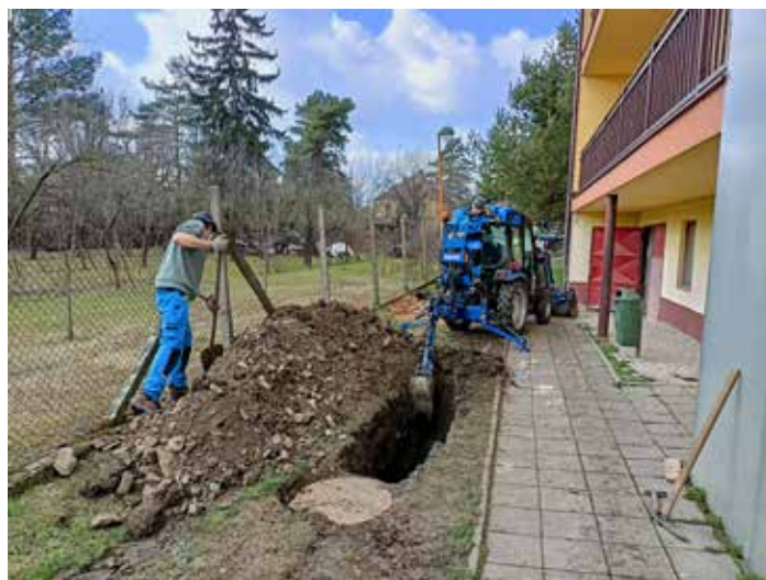
Rekonstrukce kanalizace u MŠ. 11x foto OÚ Ostrožská Lhota.
